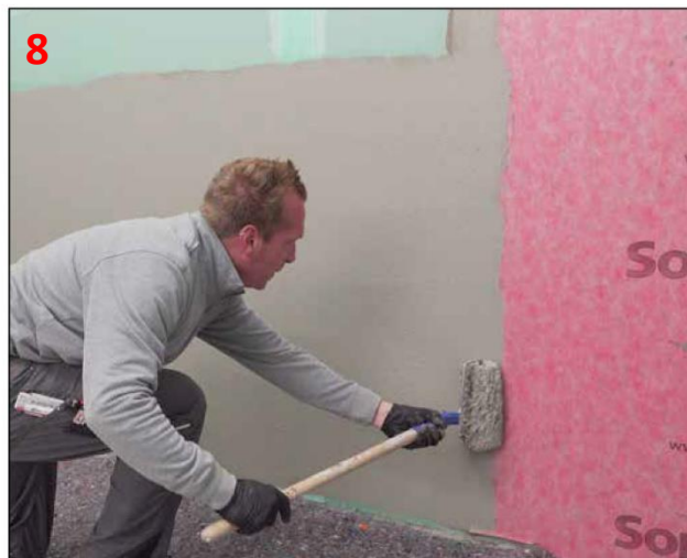
8 Wzdłuż brzegów maty Sopro AEB® 640, nanieść klej Sopro FDK 415 lub zaprawę uszczelniającą Sopro DSF® RS 623 na szerokości ok. 5 cm.
